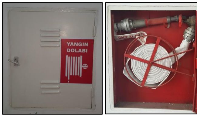
Yangın Dolabı Dış ve İç Görünüm
